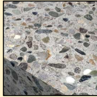
Hormigón no fisurado
